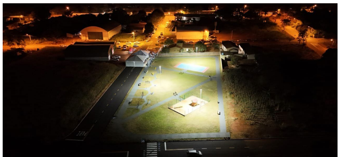
Obras entregues no povoado da Estância pela prefeitura de Jataí: investimentos de R$ 515,1 mil — Foto: Reprodução.
